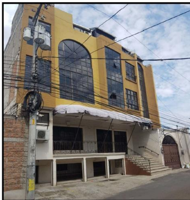
Fotografía del Edificio de la División de Certificación de Confianza
