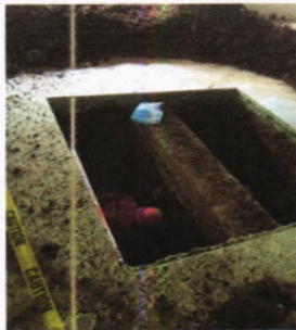
Excavaciones de zapatas en el interior del edificio
