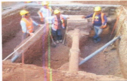
Sitio de excavación en edificio F1, se observan tuberías de aguas negras, potable y eléctricas que se removerán
