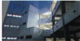
Prueba de Iluminacion en pasillos y laboratorios
