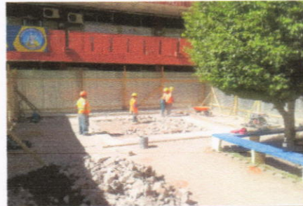
Demolición de firme de piso en sitio del cubo del elevador, Edificio A2
