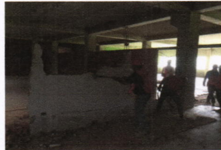
Demolición de paredes
