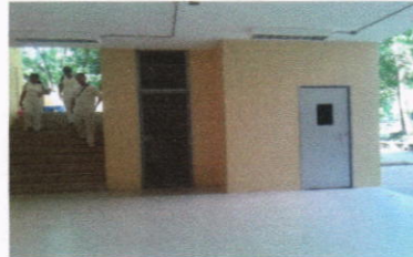
Instalación de louvers y puertas en cubo de gradas del edificio No.2
