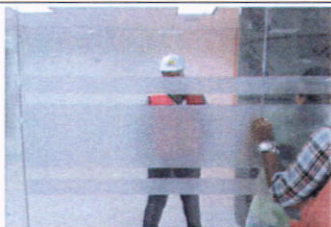
Instalación de sticker en paredes de vidrio.
