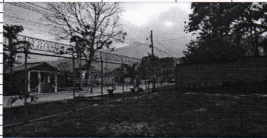
Cercos perimetral Terreno Sur Col. El Pedregal
