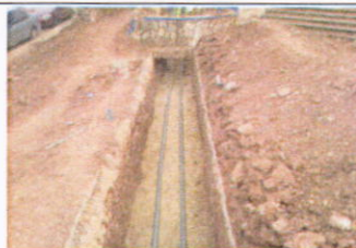
Colocación de tubería en tramo de Anillo de Media Tensión.
