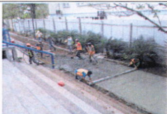
Fundición de acera en lado oeste.
