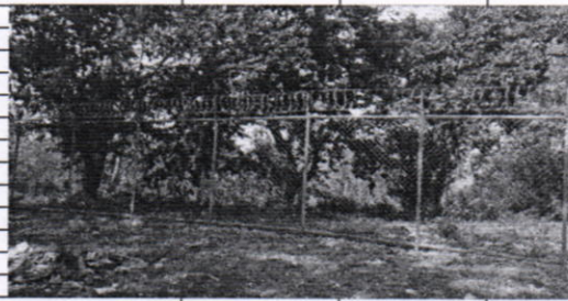
Cercos perimetral terminado terreno este
