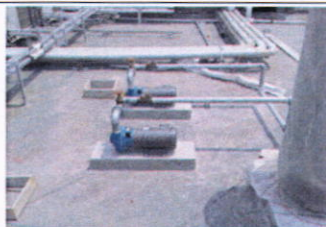
Instalación de bombas en Azotes.
