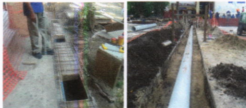
Construcción de colector de aguas lluvias edif. No.2
