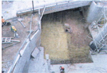
Compactación de Acceso Este al Sótano.
