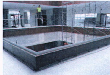
Instalación de acabados en Noveno Nivel.
