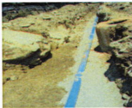
Sistema Contra Incendio: Instalación de tubería exterior
