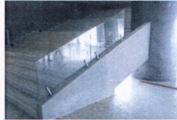
Instalación de barandal de vidrio en gradas de Planta Baja.
