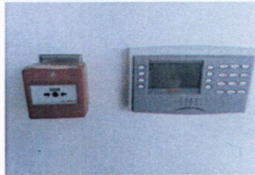
Instalación de dispositivos de seguridad.
