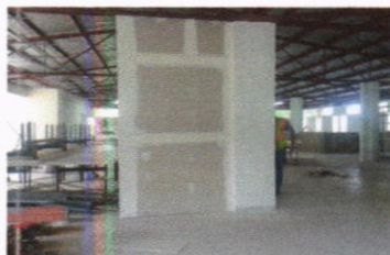
Construcción de paredes de tablados en biblioteca
