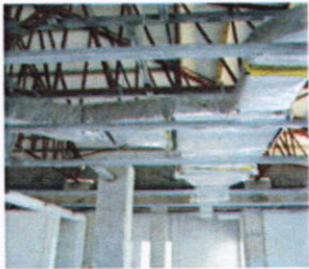
Módulo C: Colocación de Ducto de Aire Acondicionado en oficinas administrativas del tercer nivel
