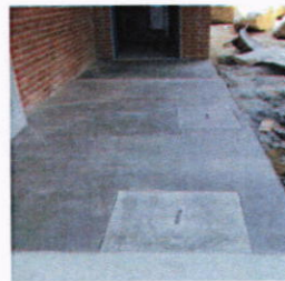
Obras Exteriores: Construcción de acera perimetral en módulo B.
