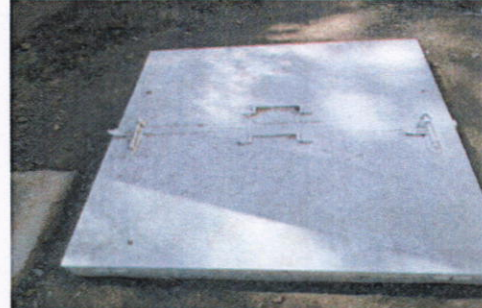
Vista de tapadera de caja eléctrica en exterior del Edificio J-1
