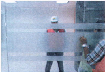
Instalación de sticker en paredes de vidrio.
