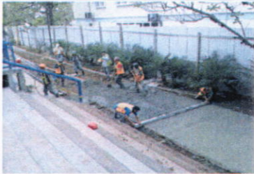
Fundición de acera en lado oeste.
