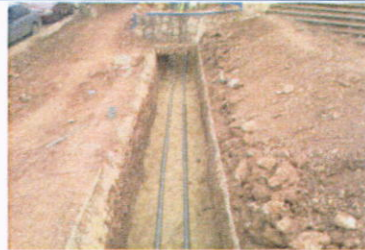
Colocación de tubería en tramo de Anillo de Media Tensión.
