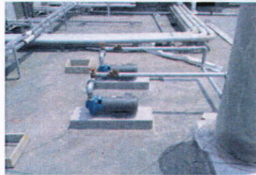
Instalación de bombas en Azotea.
