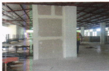
Construcción de paredes de tablayeso en biblioteca
