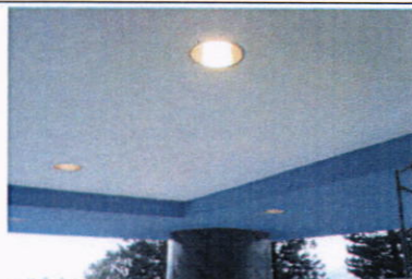
Instalación de lámparas en cielo falso del Nivel Intermedio.
