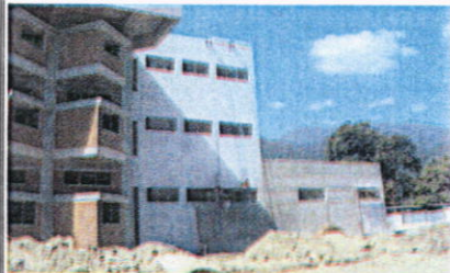
Modulo A: Pintura de paredes exteriores
