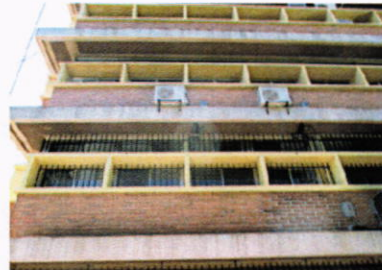
Vista de los balcones de ventanas y condensadores de aire acondicionado ubicados en ala norte del Edificio J-1
