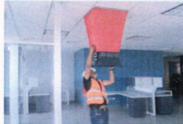
Pruebas del sistema de aire acondicionado.
