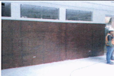
Instalación de forro de madera en el Noveno Nivel.
