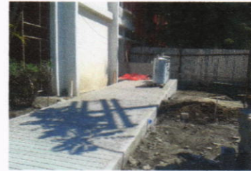
Construcción de rampa en salida de emergencia, biblioteca
