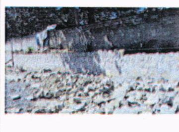
Obras Exteriores: Construcción muro de piedra en lado oeste Cuarto electrico.
