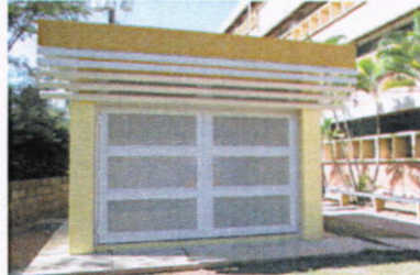
Caseta del Generador para Laboratorio de Servicios Genéticos
