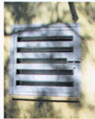
Ventana lateral de la Caseta del Generador
