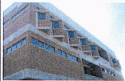
Módulo C: Instalación de vidrios en ventanas de fachadas.
