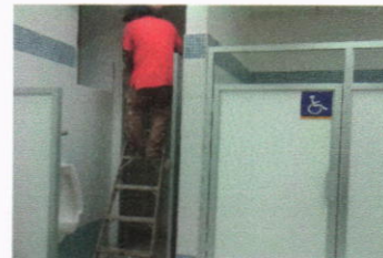
Instalación de divisiones de baño en edificio No.2
