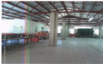
Remodelación de columnas en biblioteca
