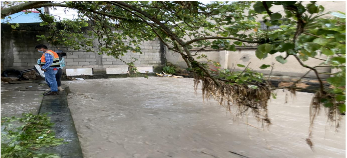
CAJA PUENTE EXISTENTE
