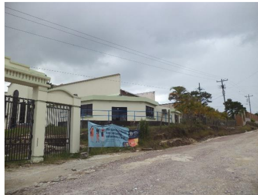
Fotografía N°3. Cerco perimetral de malla ciclón, contiguo al portal de acceso
