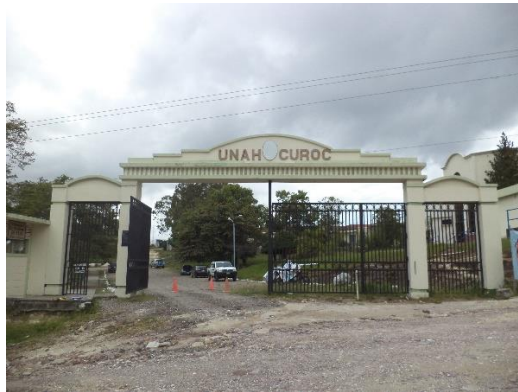
Fotografía N°2. Portal de acceso
