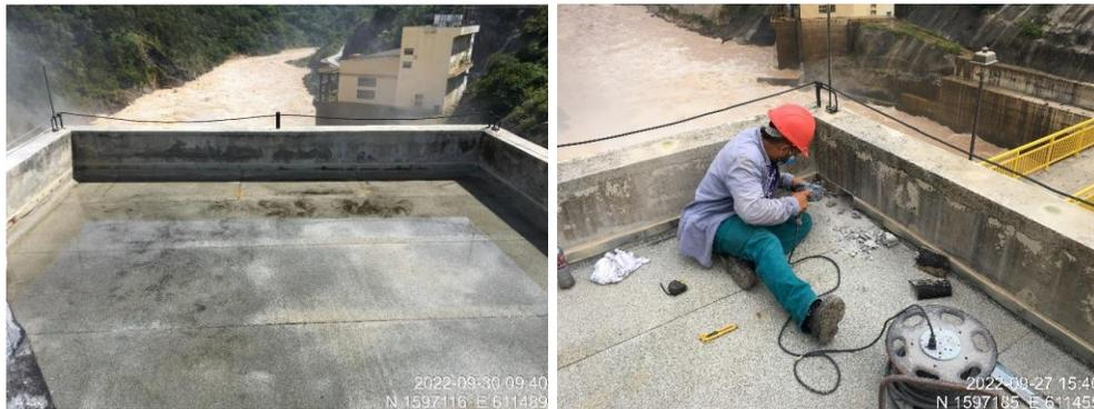
Trabajos de perforación en prétil de Cuartos de Bombas.
