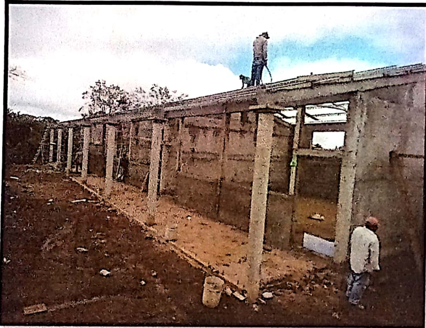
1. Levantamiento de paredes y columnas, se inicia a instalar el techo
