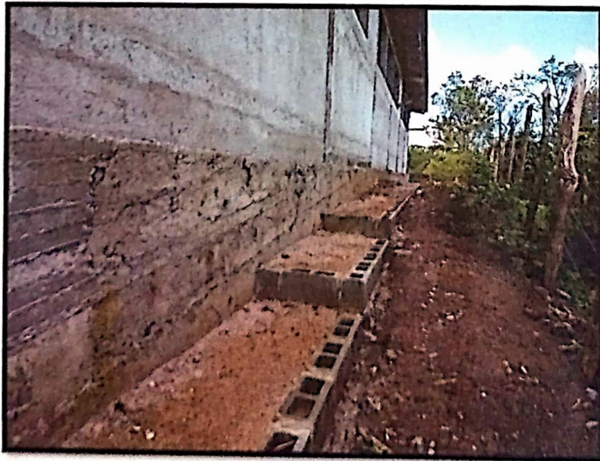
6. aceras perimetrales, se inicia construcción
