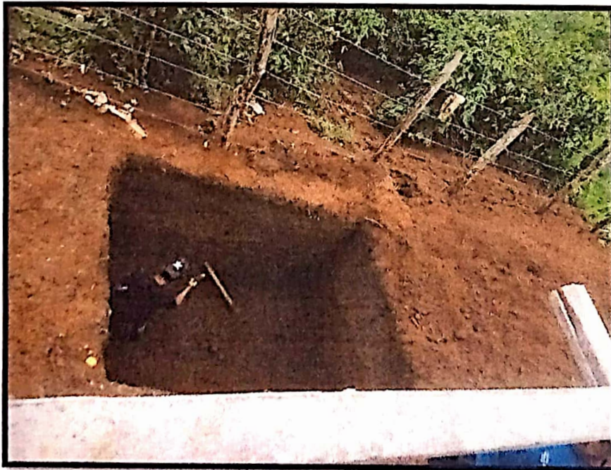
10. Excavacion para poso septico
