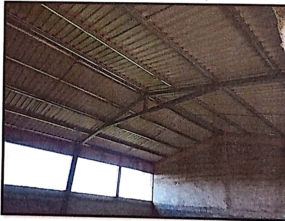
4. techo instalado en tres aulas, se observa las tlijeras
