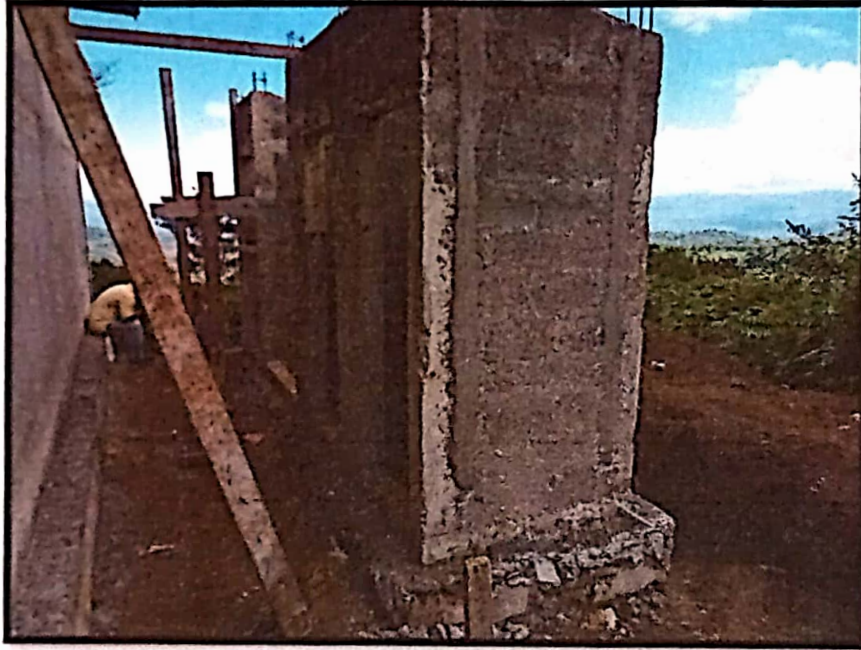
5. construcción de módulos sanitarios
