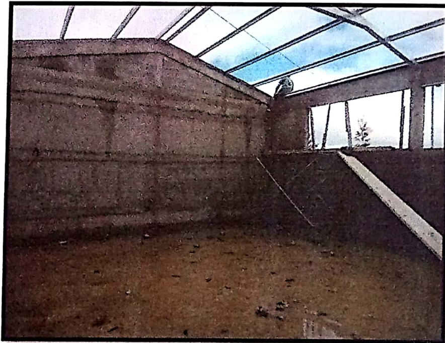
2. Instalacion de techo y repello de paredes
