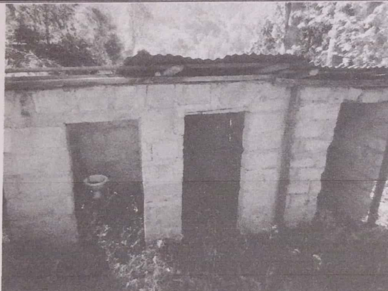
No.4 Revisión: Escuela PROHECO Buena Esperanza Fecha: Feb, 2022 Actividad: Construcción de baños sanitarios
