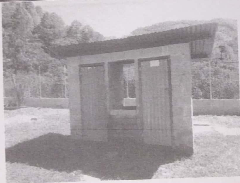
No. 4 Revisión: Escuela Oficial José Simón Ascona Fecha: Feb, 2022 Actividad: Construcción de módulos de sanitarios
