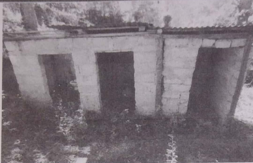
No. 3 Revisión: Escuela PROHECO Buena Esperanza Fecha: Feb, 2022 Actividad: Construcción de baños sanitarios
