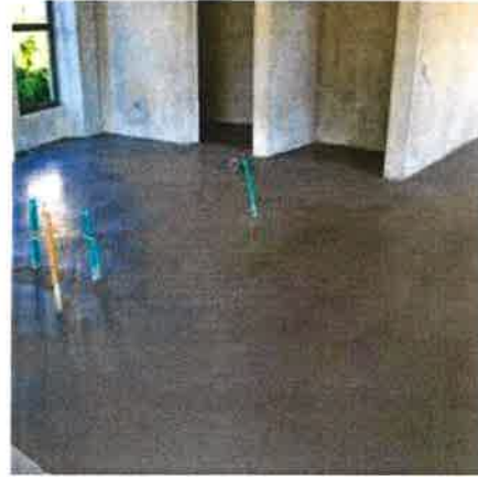
Ilustración 2 allanado de piso
