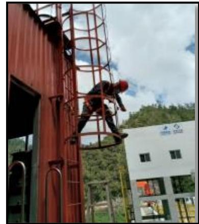
*Ilustración 1: Aplicación de pintura en la grúa limpia rejillas*
