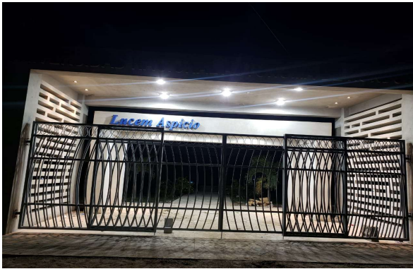
No 1.- Portón de acceso vehicular
