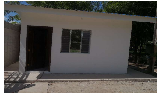
No 4.- Caseta de vigilancia
