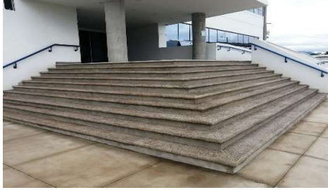
Acabado de gradas acceso Edificio Administrativo
