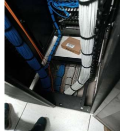
Intalacion de cableado en Data Center.
