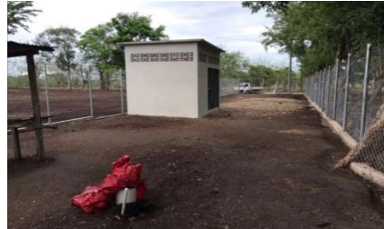
Caseta para Equipo de Bombeo del Pozo de Explotación
