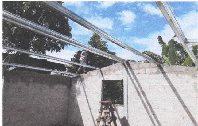
EN LAS IMÁGENES ARRIBA OBSERVAMOS COMO SE TRABAJA EN ESTRUCTURA DE CANALETA
