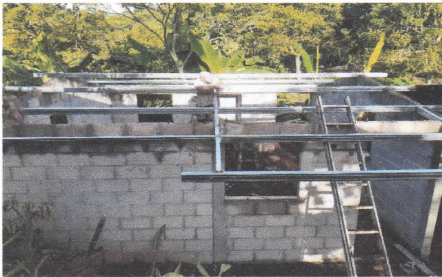
EN LAS IMÁGENES ARRIBA OBSERVAMOS COMO SE TRABAJA EN ESTRUCTURA DE CANALETA
