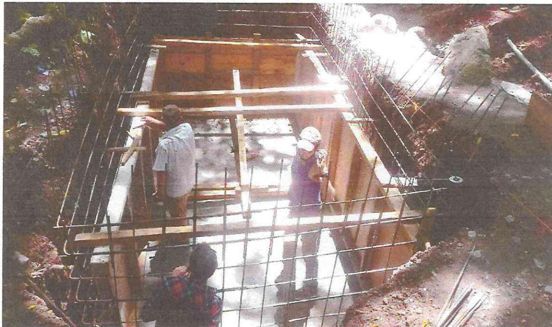
Fundición de Base de Cisterna con concreto y armado con Acero de 3/8" de paredes de la cisterna
