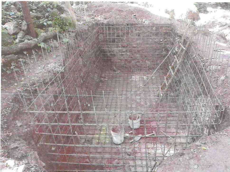
Cisterna: Armado con Acero de 3/8" de losa de piso y de paredes de la cisterna
