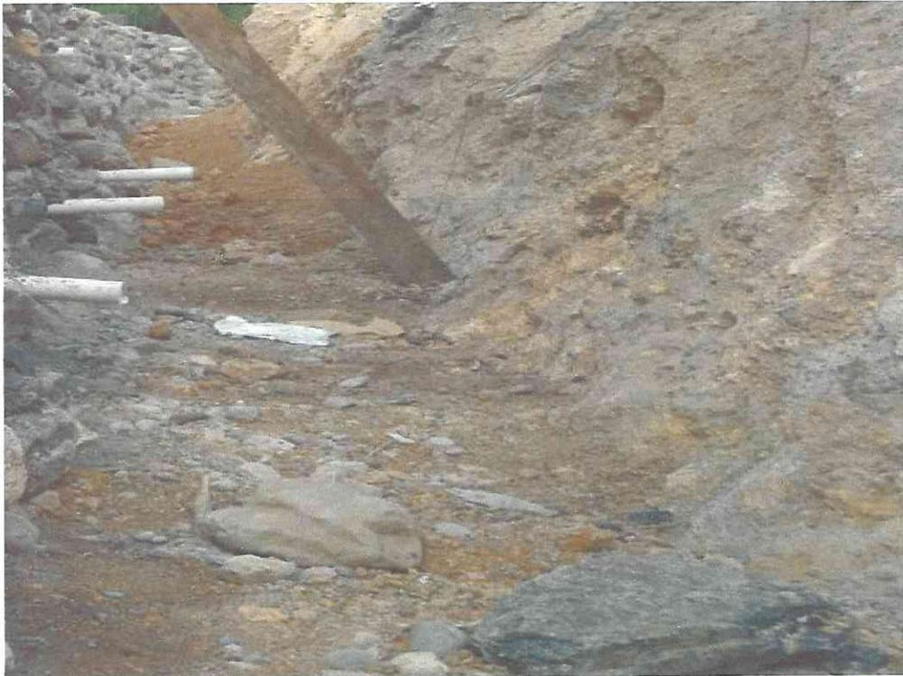
RELLENO Y COMPACTRADO PARTE POSTERIOR DEL MURO
