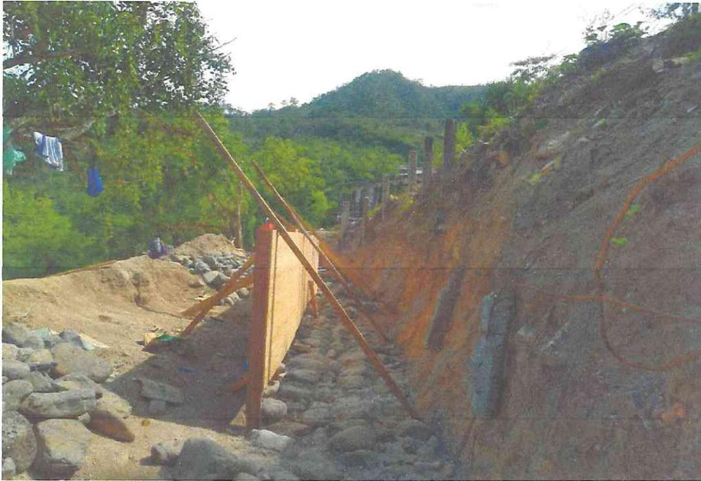
**ENCOFRADO PARA CONTINUACIÓN DE FUNDICIÓN DE CONCRETO CICLOPEO**
