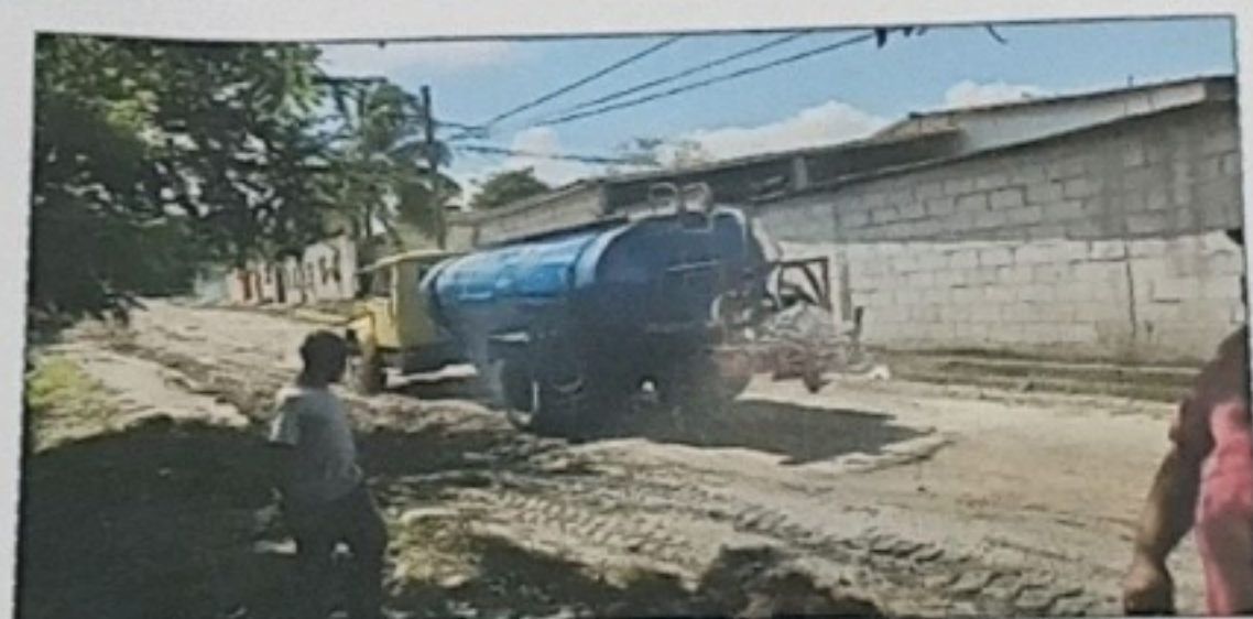
Tratamiento de humedecimiento material selecto existente
