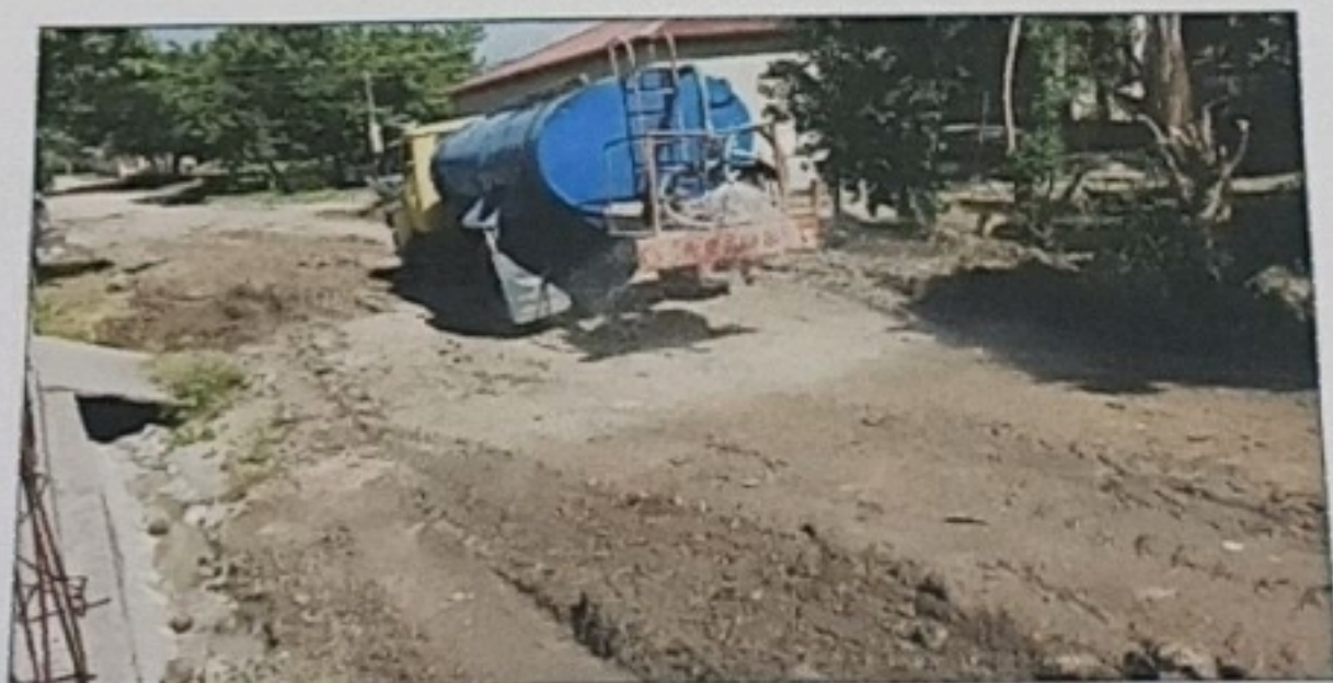
Tratamiento de humedecimiento material selecto existente
