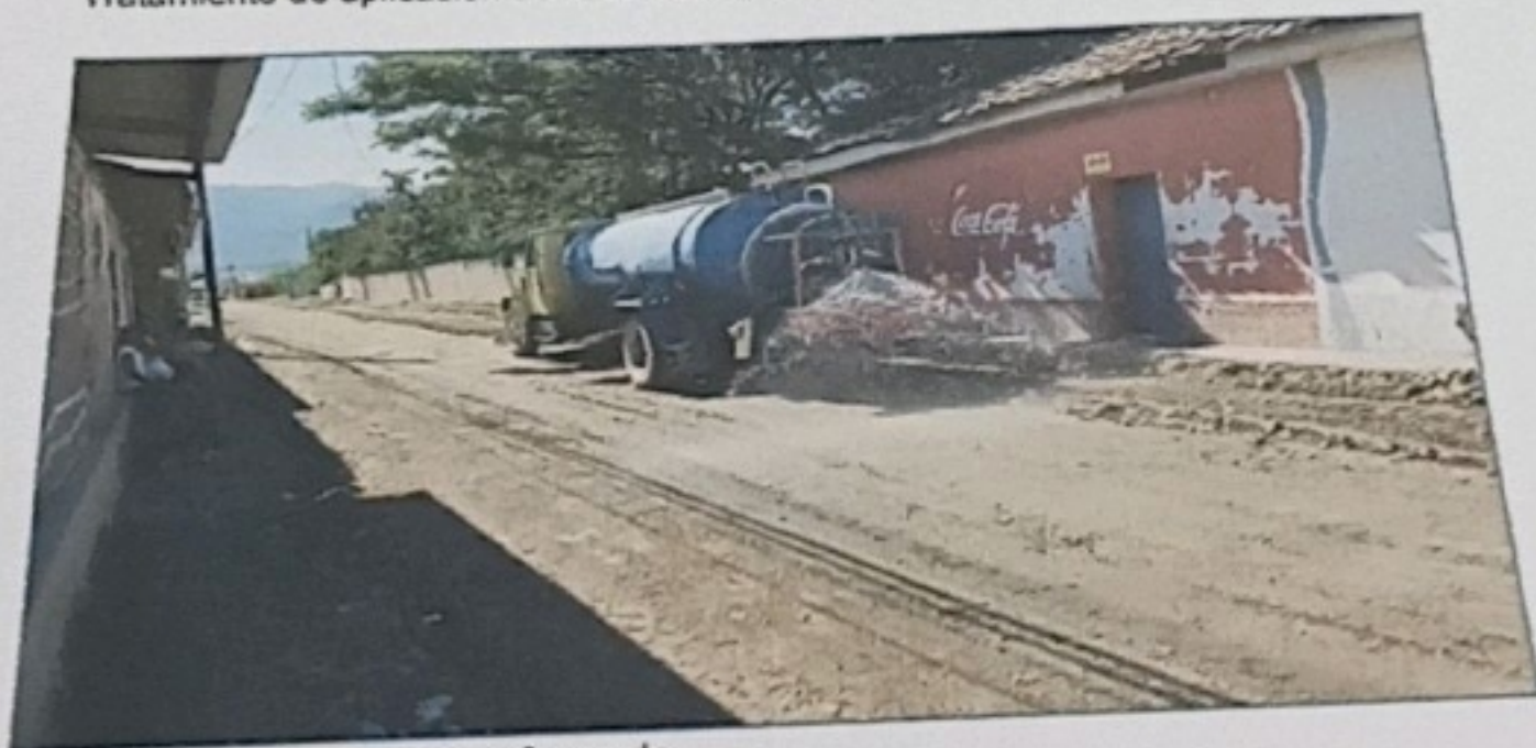
Sellado de un tramo ya conformado
