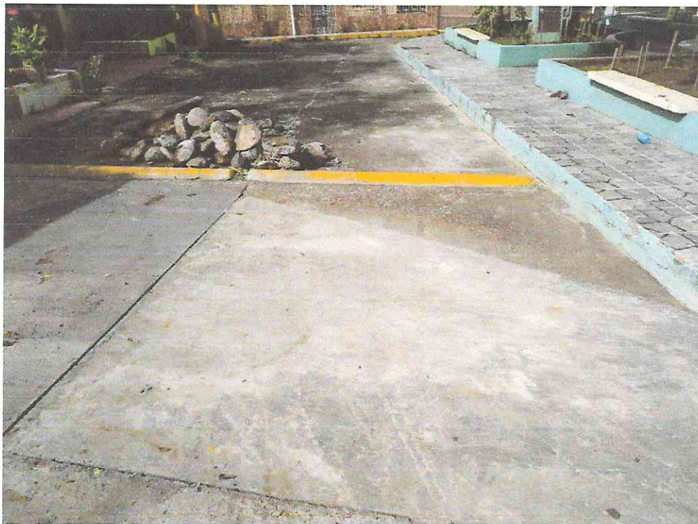
Concreto Hidráulico, corte de juntas, sellado de juntas
