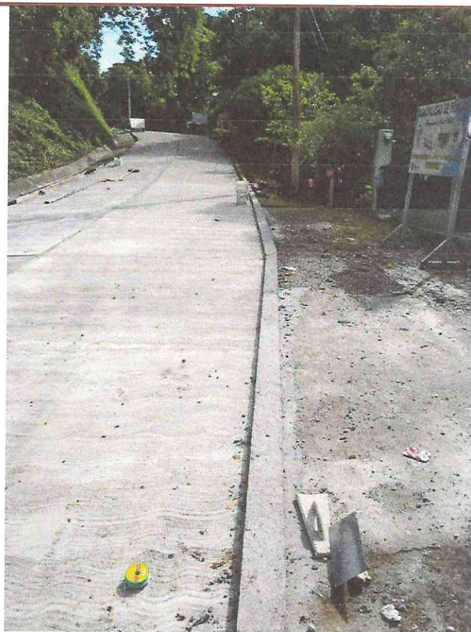
Concreto Hidráulico, Corte de juntas, sellado de juntas
