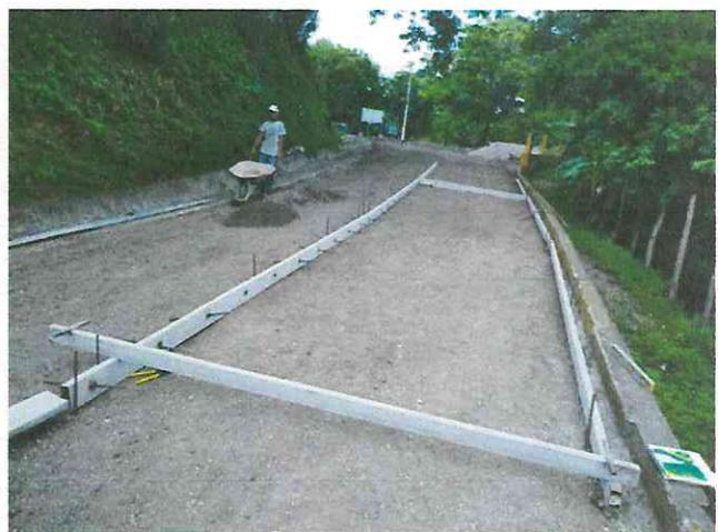
*Remocion de Capa Asfáltica, Sobre acarreo de Material y Encofrado*
