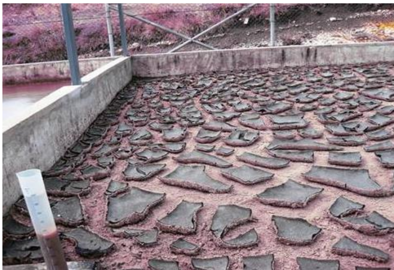
Vistas de un Patio de Secado de lodos
