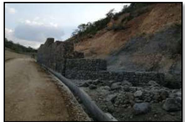
*Ilustración 3: Construcción de muro de Gaviones*
