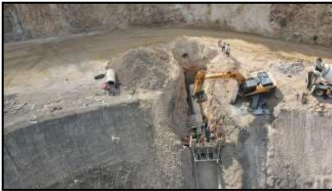
*Ilustración 2: Instalación de Tubería TCR de 60''*
