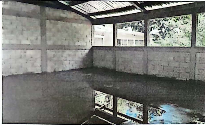
Vista interior de aula
