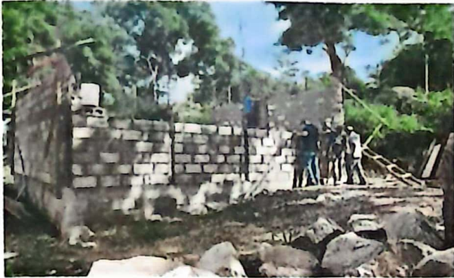
Construcción de paredes de aula
