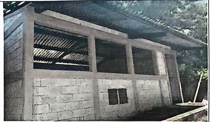
Vista exterior del aula terminada incluyendo instalación del techo
