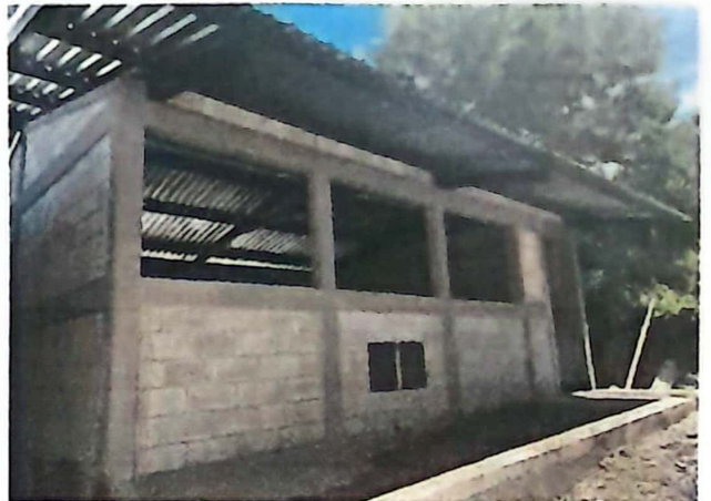
Vista frontal del techo instalado en aula de prebasica
