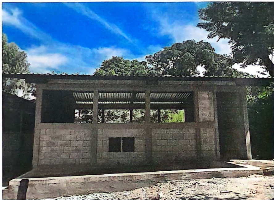
Vista exterior del aula con la estructura de techo instalada en CENTRO DE EDUCACION PREBASICA LIC. MARLENI COREA EN LA COMUNIDAD DEL OCOTILLO
